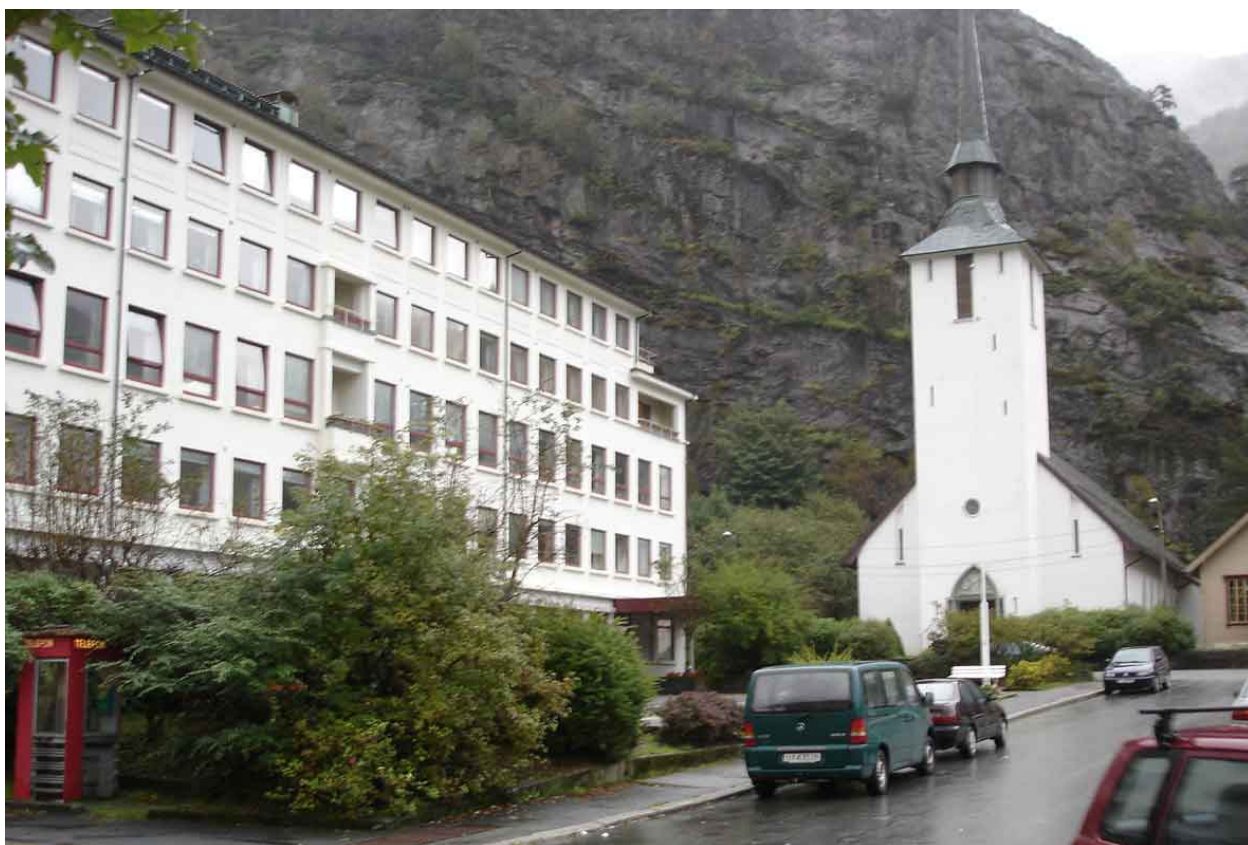
Heradshuset og Kirken i Dale sentrum har vannbåren oppvarming
