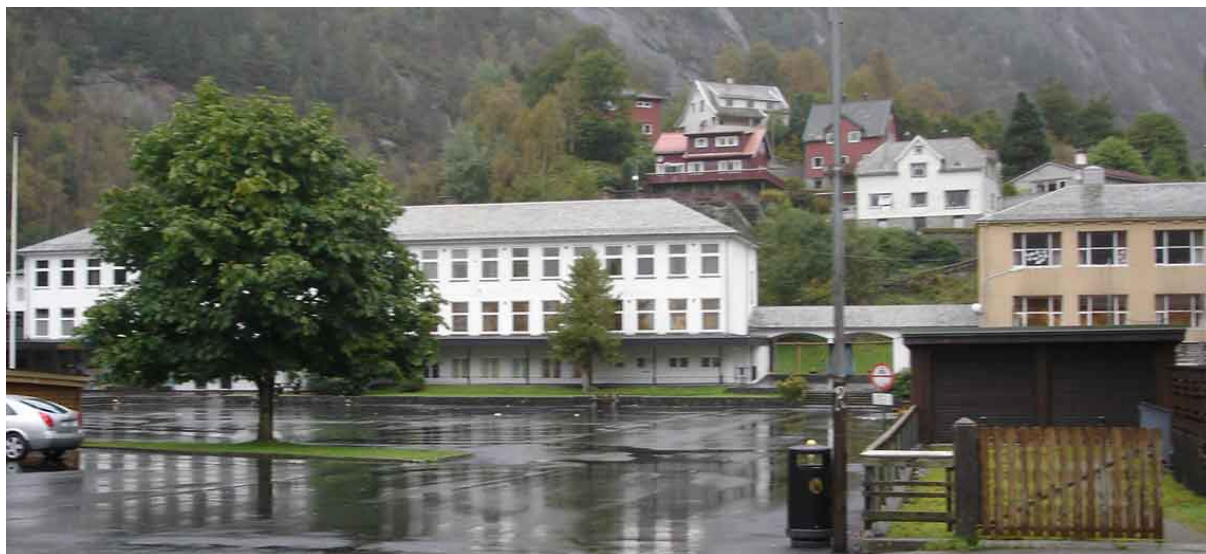
Figur 2-1, Dale Barne- og Ungdomsskole som har vannbåren oppvarming.
