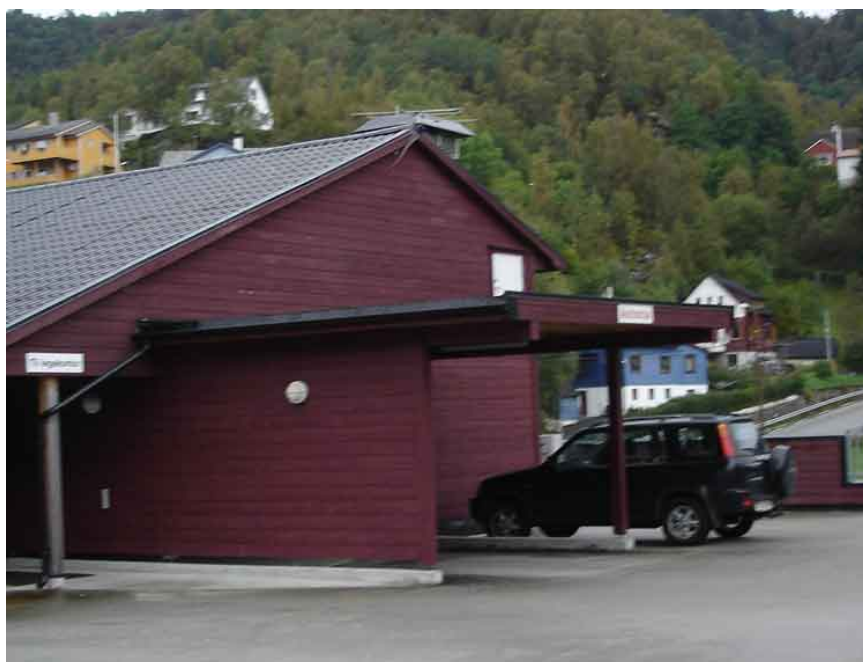
Figur 2-2, Osterøy helsesenter med ventilasjonsanlegg på taket (nr.4)
