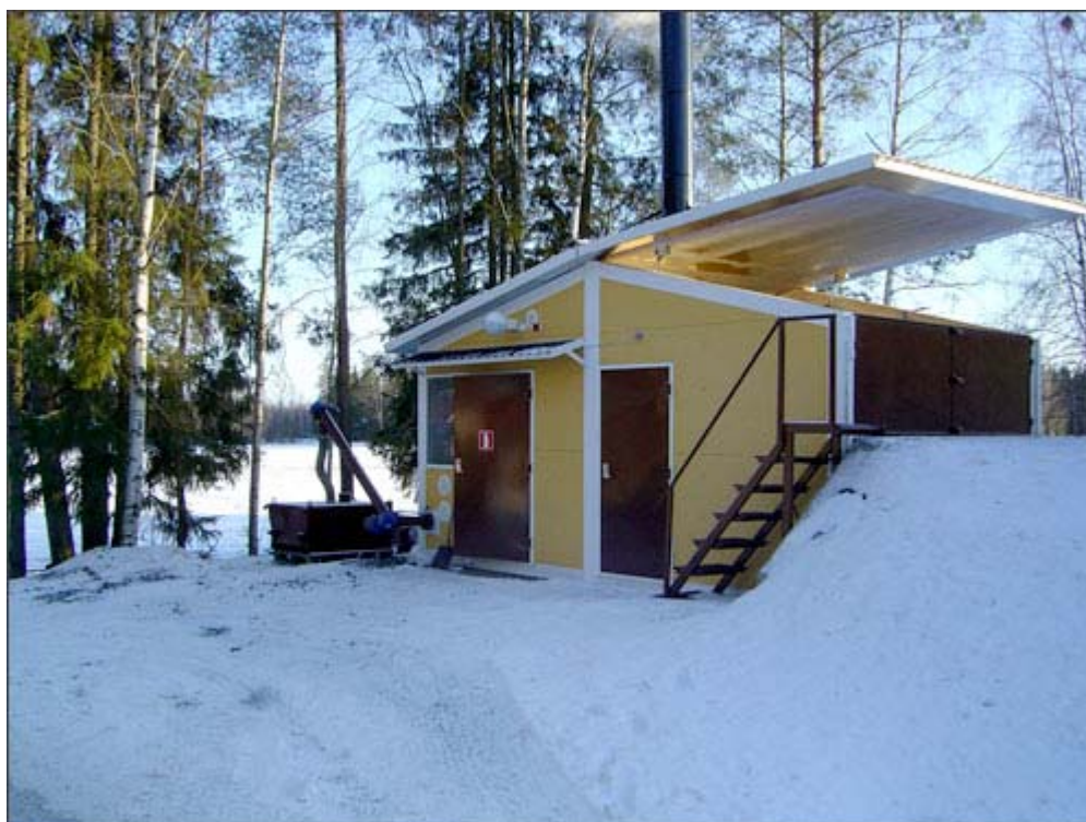
Figur 4-4 eksempel på biobrenselenheten på 250 kW fra Hallenstvedt
