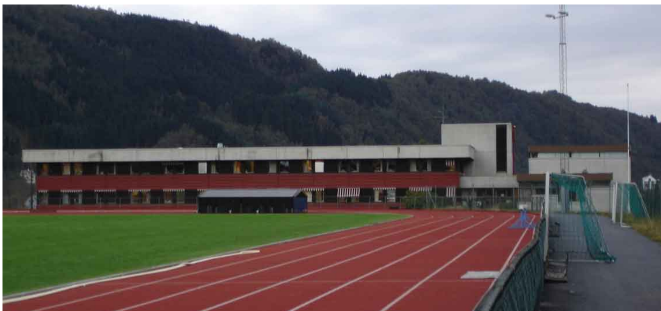
Lonevåg Rådhus som er elektrisk oppvarmet
