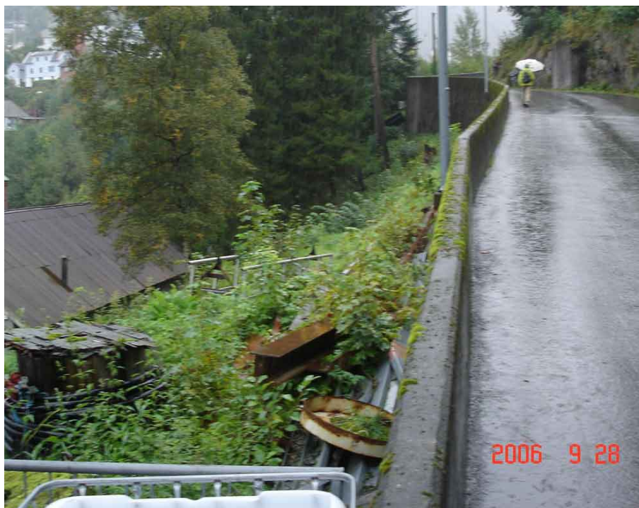
Figur 4-4, Bilde som viser veien opp fra eksisterende fyrsentral.
