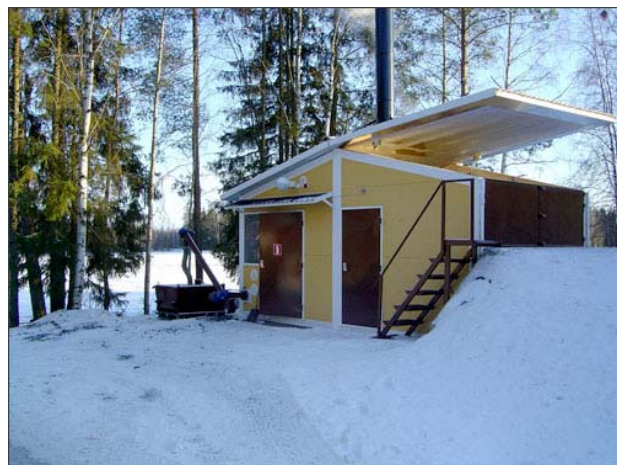
Figur 4-3 Container enhet med flisslager til venstre og biokjel til høyre på det venstre bildet og omvendt til høyre.
